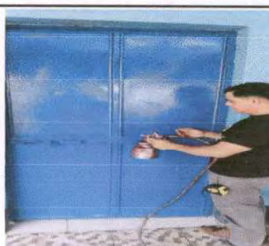
Foto 18: Reparación y mantenimiento de puerta de aula 3, por custiones de colocación de piso se tendrá que modificar. Medida de puerta 2m de altura por 1 de ancho.
