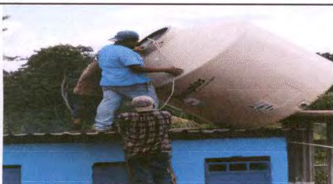
Foto 29: Se sustituirá el depósito de agua porque la cantidad de litros no abastece los días en que no llega el agua a la escuela (20 días o más). Se colocará uno de 2500 litros por uno de 1100 litros.
