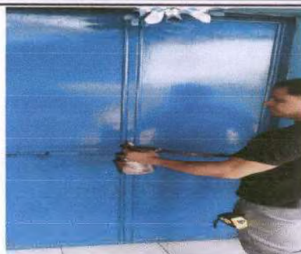
Foto 14: Reparación y mantenimiento de puerta de aula 2, por custiones de colocación de piso se tendrá que modificar. Medida de puerta 2m de altura por 1 de ancho.
