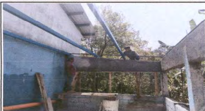
Foto 1: Cambio de techo por deterioro de las láminas , cantidad de metros 24 m².
