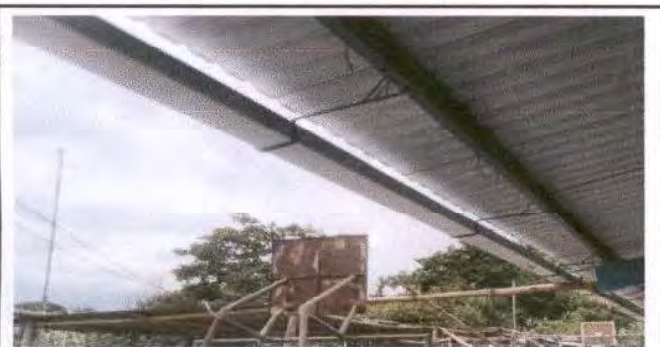
Foto 23: Colocación de canales de metal y bajada de agua pluvial, se hará con el propósito que en su momento pueda hacerse un tanque de concreto para guarda el agua. Total de metros lineales 24 y una bajada de
