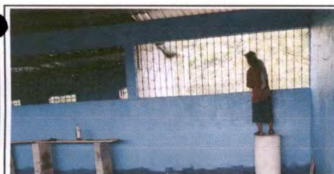
Foto 11: Mantenimiento a balcones de metal por deterioro en pintura aula 1, total de metros 12, son dos lados de 6 metros cada uno.
