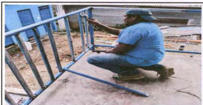
Foto 24: Sustitución de barandal de metal, por motivo que el material ferroso está picado en un porcentaje considerable. Cantidad de metros 8m².
