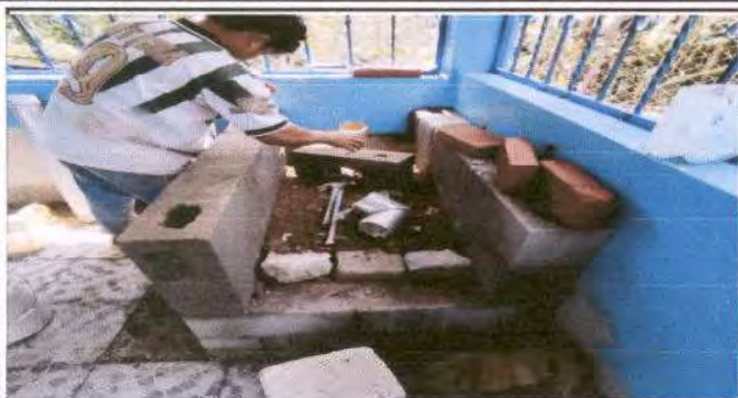
Foto7: Construcción de estufa con plancha de metal con las medidas 1.80 m de largo por 1.0 m de ancho, incluye chimenea.
