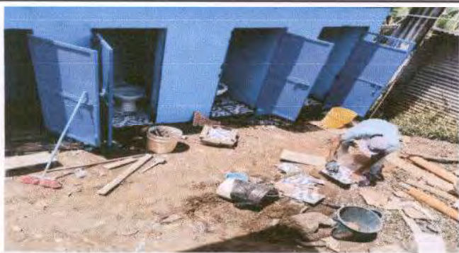
Foto 27: Colocación de piso cerámico antideslizante en los 4 espacios que conforman el módulo de baños debido al deterioro del piso liso. Total de metros 6 m².
