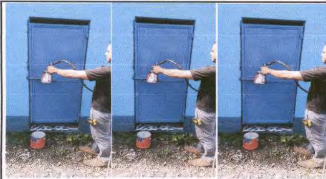
Foto 25: Mantenimiento a 3 puertas de los baños por deterioro en pintura y estructura. Medidas de las puertas 1.46 m de altura por 0.63 m de ancho.
