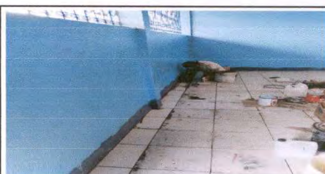
Foto 12: En aula 1 se colocará piso cerámico debido al deterioro del piso liso. Total de metros 51.5 m 2 .
