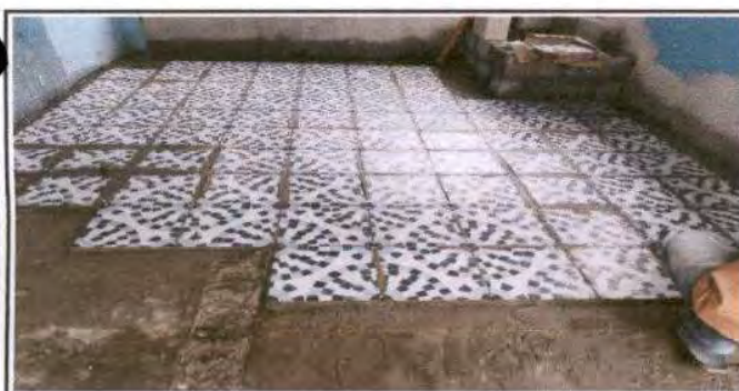
Foto 5: Colocación de piso cerámico antideslizante en la cocina escolar, cantidad de metros 23 m²
