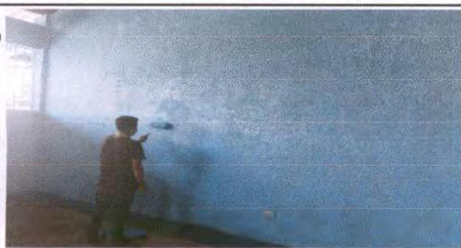
Foto 17: Pintura de aula 2 se pintará debido al tiempo y falta de pintura en algunos segmentos de la pared. Total de metros 98.33 m²
