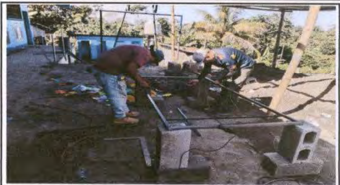
Foto 26: Sustitución de puerta madera por una de metal, medidas de las puertas 1.46 m de altura por 0.63 m de ancho.
