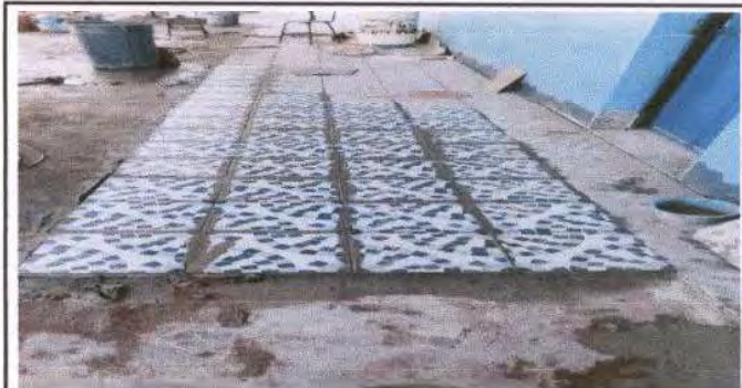
Foto 22: Colocación de piso cerámico antideslizante, debido al deterioro del piso liso, por sus años de construcción. Total de metros 44 m².
