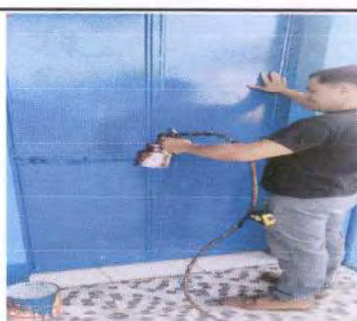
Foto 10: Reparación y mantenimiento de puerta de aula 1, por custiones de colocación de piso se tendrá que modificar. Medida de puerta 2m de altura por 1 de ancho.
