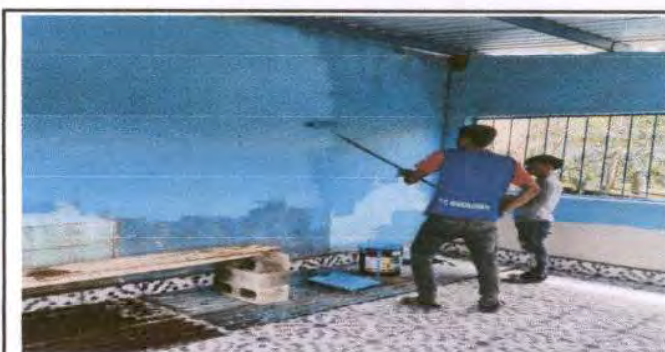
Foto 6: Pintura en paredes interiores y exteriores de la cocina, cantidad de metros 32 m²
