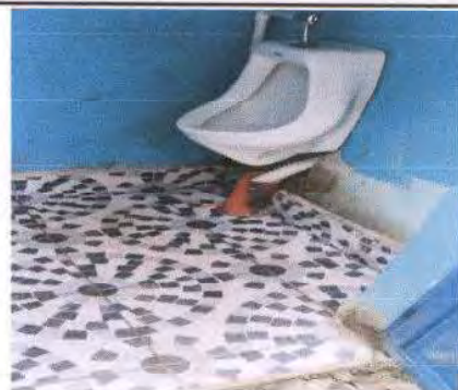
Foto 28: Instalación de mingitorio, para que los estudiantes ya no orinen en este espacio y cause malos olores.
